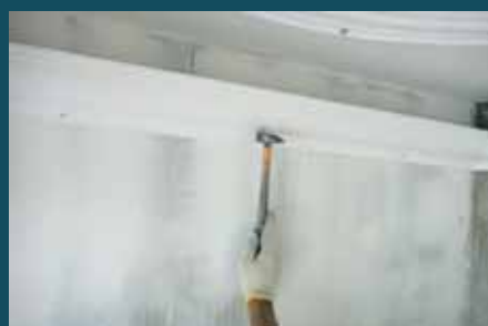
8. Зафиксируйте приклеиваемое изделие на стене с помощью гвоздиков до полного отверждения клея, чтобы предотвратить сползание
