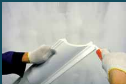
5. На торец изделия нанесите стыковочный клей
