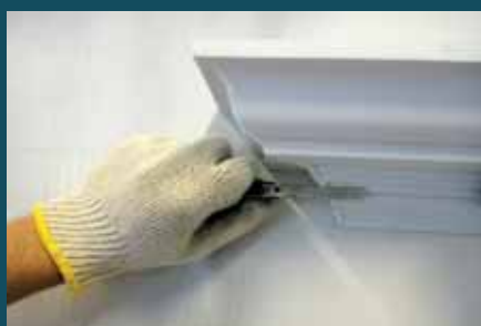
9. Через 24 часа удалите ножом излишки стыковочного клея. Также удалите гвоздики и скобы от степлера
