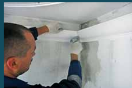
7. Место стыка зафиксируйте строительным степлером
