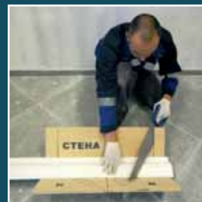
Монтаж лепного декора
